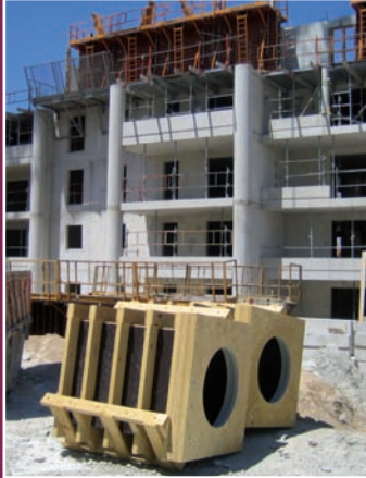
Ouvrage : Coffrage de poteau
