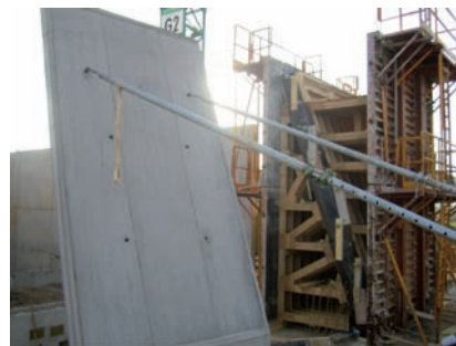
Ouvrage : Coffrage voile incliné
