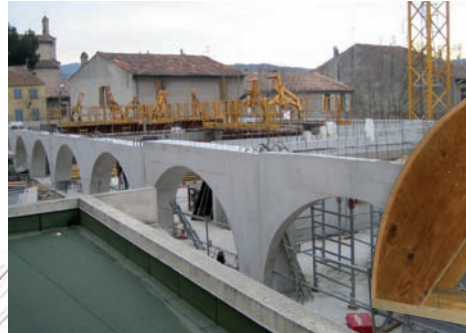
Ouvrage : Coffrage de voûte
